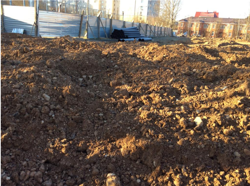
Рис. 9. Объект «Дошкольная образовательная организация на 125 мест по адресу: г. Калуга, ул. Заречная, в районе д. 72». Вид с северо-востока.
