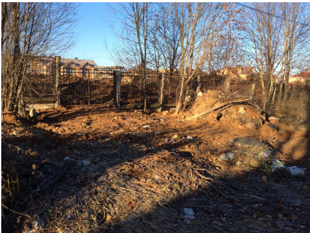
Рис. 7. Объект «Дошкольная образовательная организация на 125 мест по адресу: г. Калуга, ул. Заречная, в районе д. 72». Вид с юго-востока.
